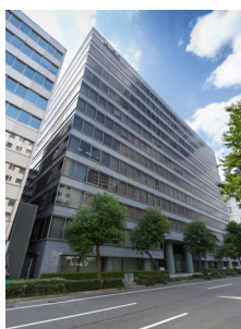
グローバル・ワン 名古屋伏見 (愛知県名古屋市)
