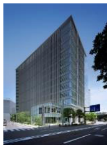
横浜プラザビル (神奈川県横浜市)
