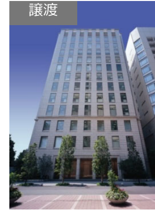
淀屋橋フレックスタワー
