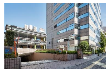
<屋内型自走式駐車場>
