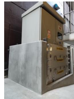
止水板の設置
