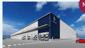
(仮称) 谷田部物流センター 2025年2月竣工予定
