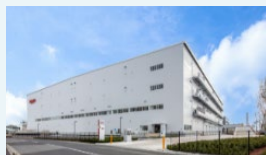
松戸物流センター 2022年1月竣工
