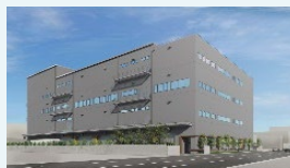
東京東雲物流センター 2024年11月竣工予定
