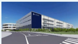
ロジポート多摩瑞穂 2024年6月竣工予定
