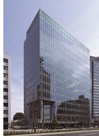
花京院プラザ (宮城県仙台市)
