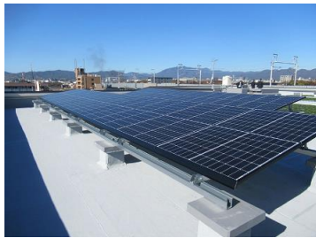
太陽光パネルの設置 (グランカーサ京都駅前)
