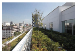
屋上庭園の設置 (Daiwa麻布テラス)
