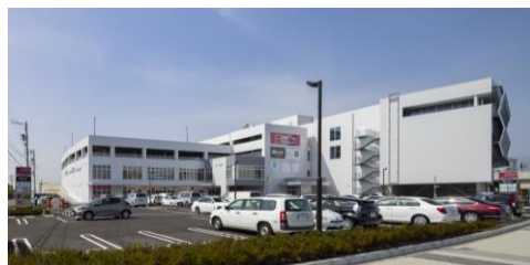
北面都市計画道路より
