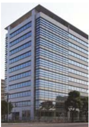
A-18 晴海センタービル
