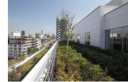
屋上庭園の設置 (Daiwa麻布テラス)
