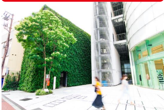
壁面緑化 (ブリーゼタワー)
