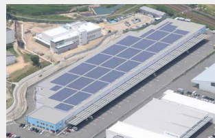
IIF鳥栖ロジスティクスセンター
