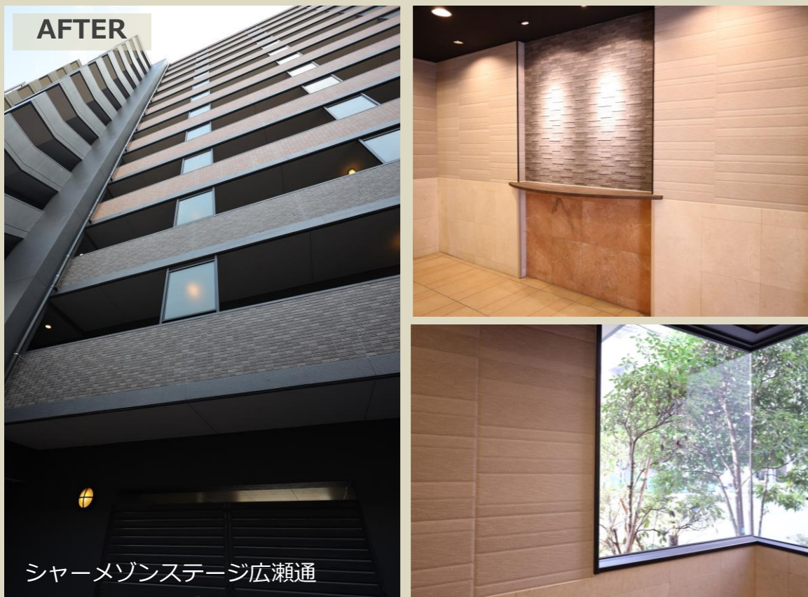
外装をシックな色合いに変更・エントランス壁面は織物の質感を表現した上品なデザインのタイル貼り
