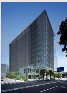
横浜プラザビル
