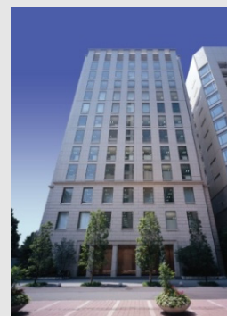
淀屋橋フレックス タワー
