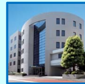
アーバンネット市ヶ谷ビル
