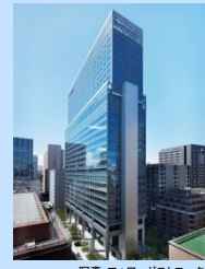
写真：フォワードストローク アーバンネット 内幸町ビル 延床面積：36,145.48㎡
