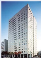
仙台MTビル
