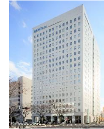
仙台MTビル
