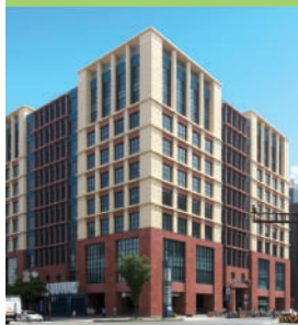
呉服町ビジネスセンター
