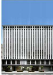
B-18 四条烏丸センタービル
