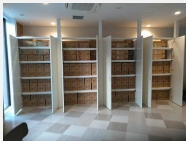
備蓄用キャビネット増設工事
