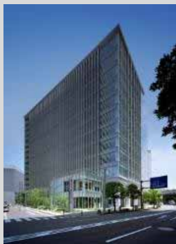
横浜プラザビル
