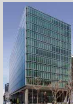
明治安田生命 大阪御堂筋ビル
