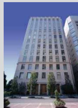
淀屋橋フレックス タワー
