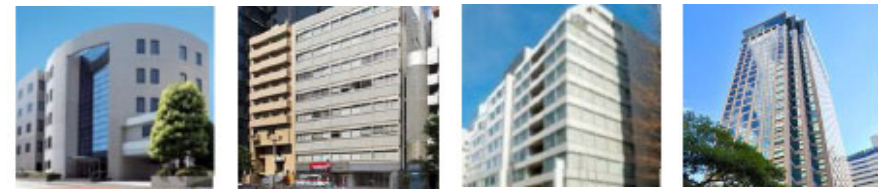
アーバンネット 市ヶ谷ビル アーバンネット 麹町ビル ビュロー紀尾井町 スフィアタワー天王洲
