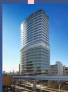
浜離宮インターシティ
