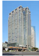
日石横浜ビル
