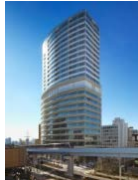
浜離宮インターシティ
