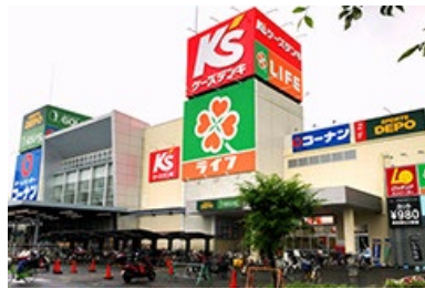
高槻市と災害時協力協定を締結、 災害時の車輛拠点を提供 (高槻城西ショッピングセンター)
