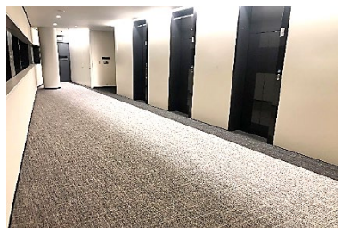
共用部の床をカーペット張りに、 歩きやすいとテナントから好評 (汐留イーストサイドビル)
