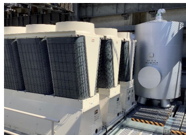
計画的な修繕の実施 (ラグザ大阪熱源更新工事)
