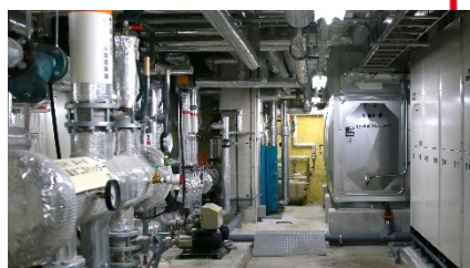
地中熱や温泉排湯を空調や給湯の熱源にするヒートポンプ設備
