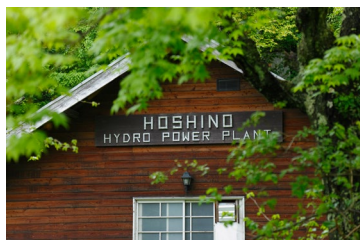
ヒートポンプの動力の一部を賄う水力発電設備
