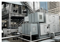
空調設備の更新 (Daiwa赤坂ビル)
