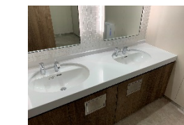
洗面器具等の更新 (Daiwa南青山ビル)
