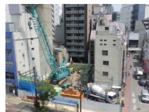
<着工時現場写真(2021年6月末)>
