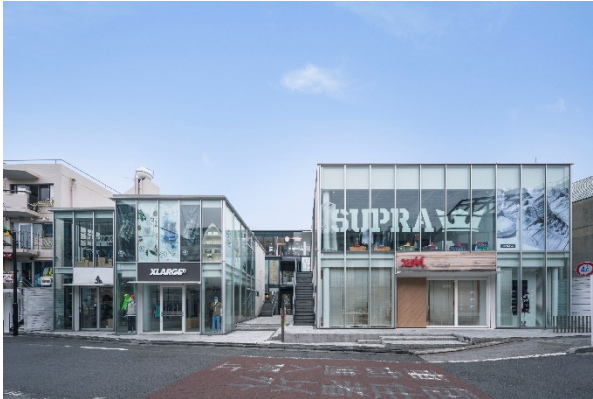
外観（左：B棟 右：A棟）
