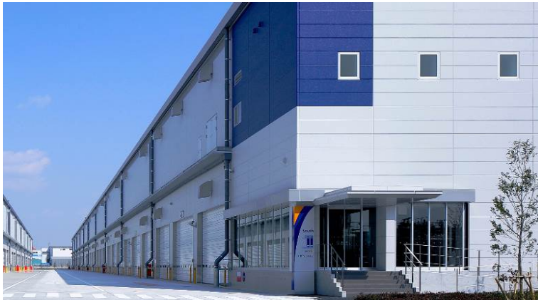
ロジポート堺（南棟）（大阪府堺市西区築港新町2丁目7番地9）
