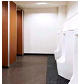
トイレ機器更新による 節水
