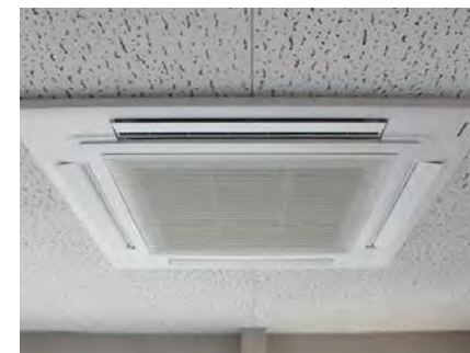
空調設備更新
