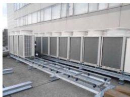
空調設備の更新
