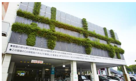
太陽光パネル
