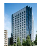
大崎MTビル
