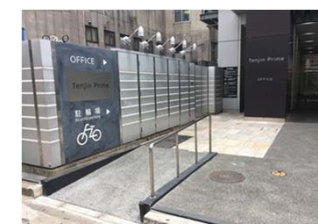
バリアフリー改修工事(天神プライム)
