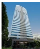
紀尾井町ビル
