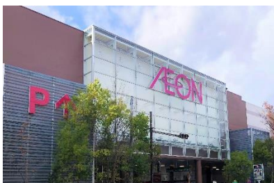
外壁塗装工事
