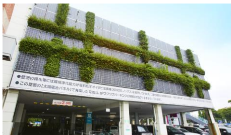
太陽光パネル
