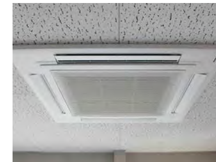
空調設備更新
