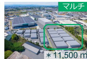
● プロロジスパーク古河7 (茨城県古河市) 2026年2月竣工予定
