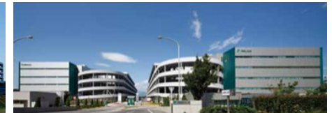
M-10 プロロジスパーク座間2 M-02 プロロジスパーク座間1
