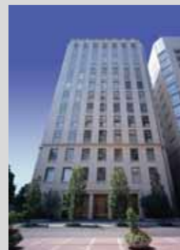
淀屋橋フレックス タワー
