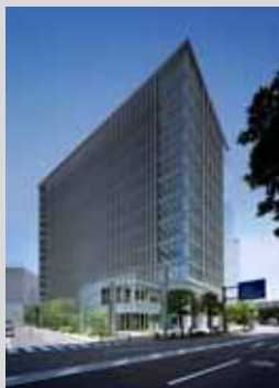
横浜プラザビル
