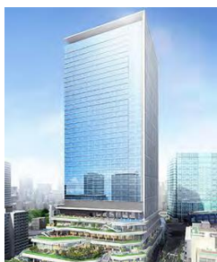
東京ポートシティ竹芝 2020年5月竣工 港区 オフィス/商業/住宅 延床面積：201千㎡
