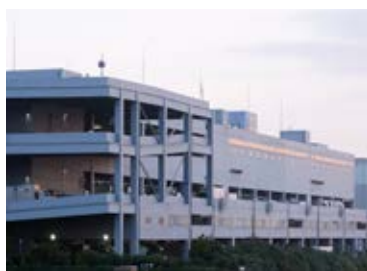
IIF東雲ロジスティクスセンター
