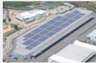
IIF鳥栖ロジスティクスセンター
