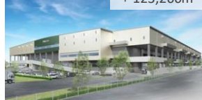
プロロジスパーク古河4 (茨城県古河市) 2023年3月竣工予定
