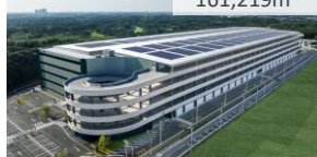
プロロジスパーク八千代1 (千葉県八千代市) 2022年9月竣工
