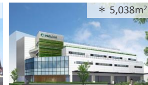
プロロジスアーバン 東京大田1 (東京都大田区) 2023年2月竣工予定
