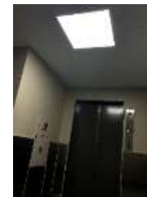
（非常用エレベーターホール）
