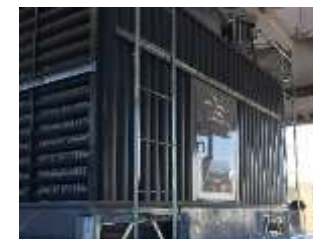
【横浜STビル】
