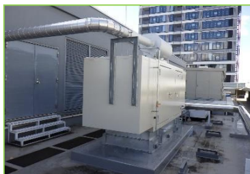
（NBF高輪ビル）
