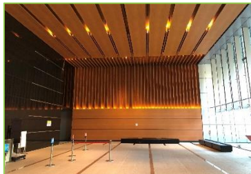
【特定天井耐震対策】（NBF豊洲キャナルフロント）
