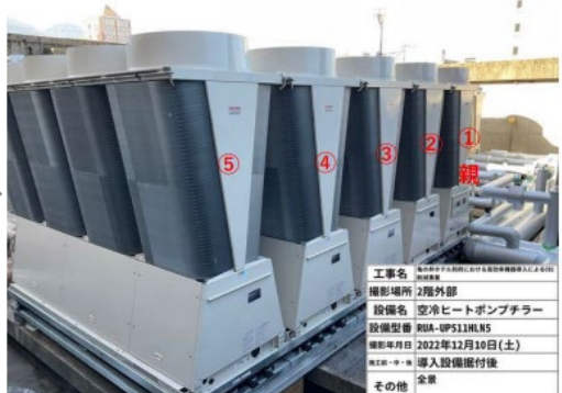
空冷ヒートポンプチラー据付後
