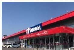
① ヤマダ電機テックランド 札幌白石店/底地
