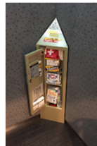
ELV内 防災キャビネット
