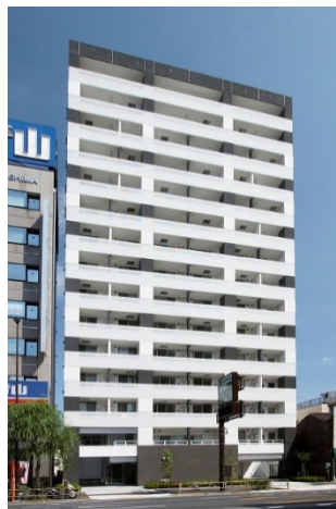
プロスペクトKALON ミノ輪 (東京都台東区 2007年竣工) 工事費 23百万円
