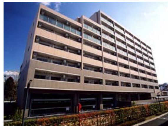
フォレスト・ヒル仙台青葉 (宮城県仙台市 2007年竣工) 工事費 99百万円
