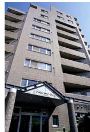
グリーンパーク小松島 (仙台市青葉区 1990年竣工) 工事費 22百万円
