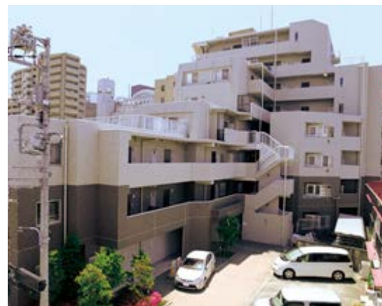
リエトコート四谷 (東京都新宿区 2006年竣工) 工事費 72百万円
