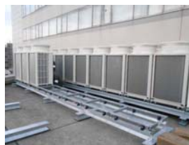
空調設備の更新
