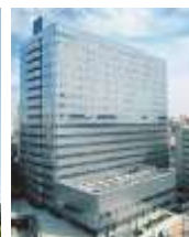
横浜STビル (神奈川県横浜市)
