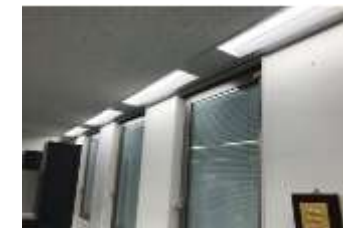
【住友電設ビル 専有部】
