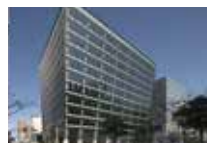
博多FDビジネスセンター
