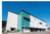
・物流施設 ロジシティ久山
