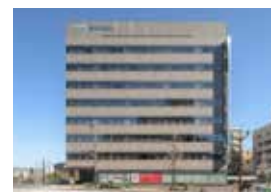
熊本イーストフロントビル
