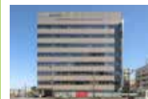
熊本イーストフロントビル
