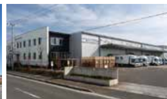
鳥栖ロジスティクスセンター
