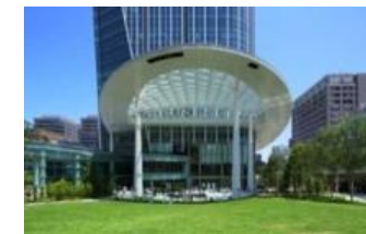
屋上庭園「オーバル広場」
